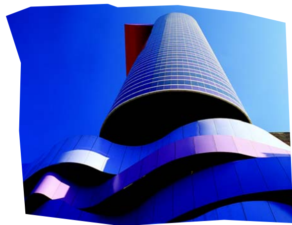
Fachada do Instituto Tomie Ohtake
